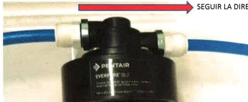
SEGUIR LA DIRECCION DE LA FLECHA DEL CABEZAL
